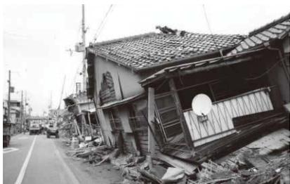
**A:**1階部分が押しつぶされて倒壊しています。
